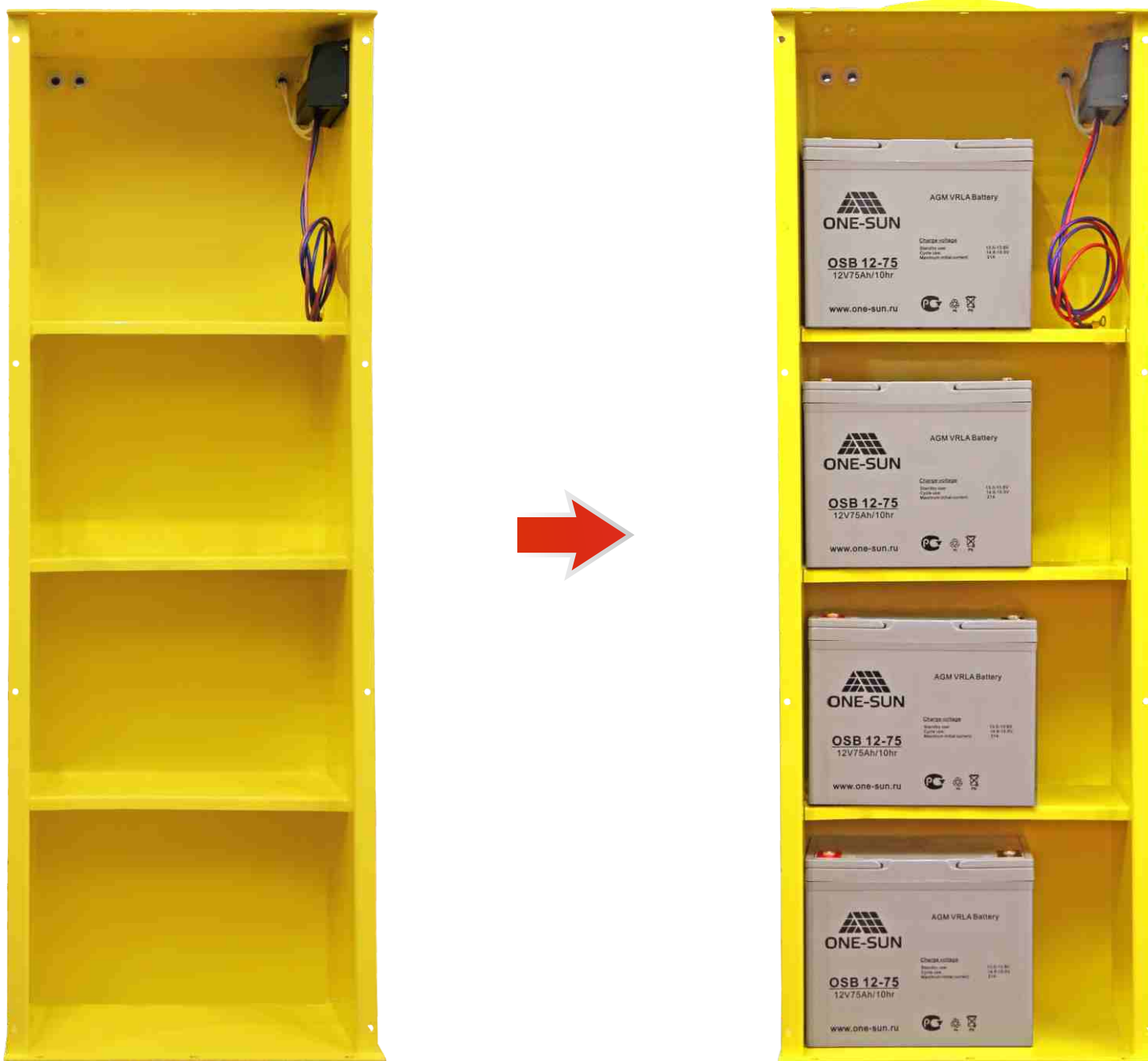
Установить аккумуляторные батареи на полки ящика как показано на фото.
